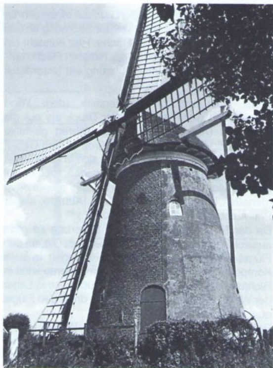
Abb. 22 Holländische Mühle, drehbare Dachkonstruktion
