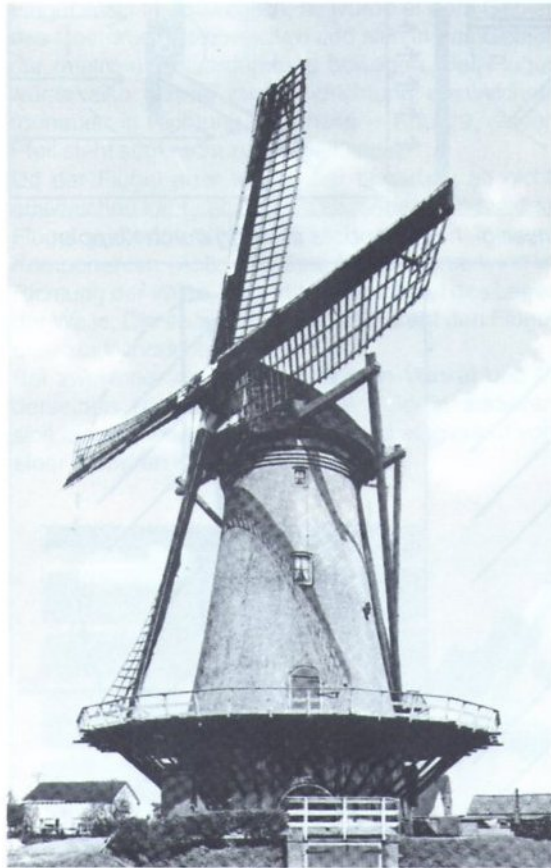
Abb. 6 Holl. Mühle, drehbares Dach
